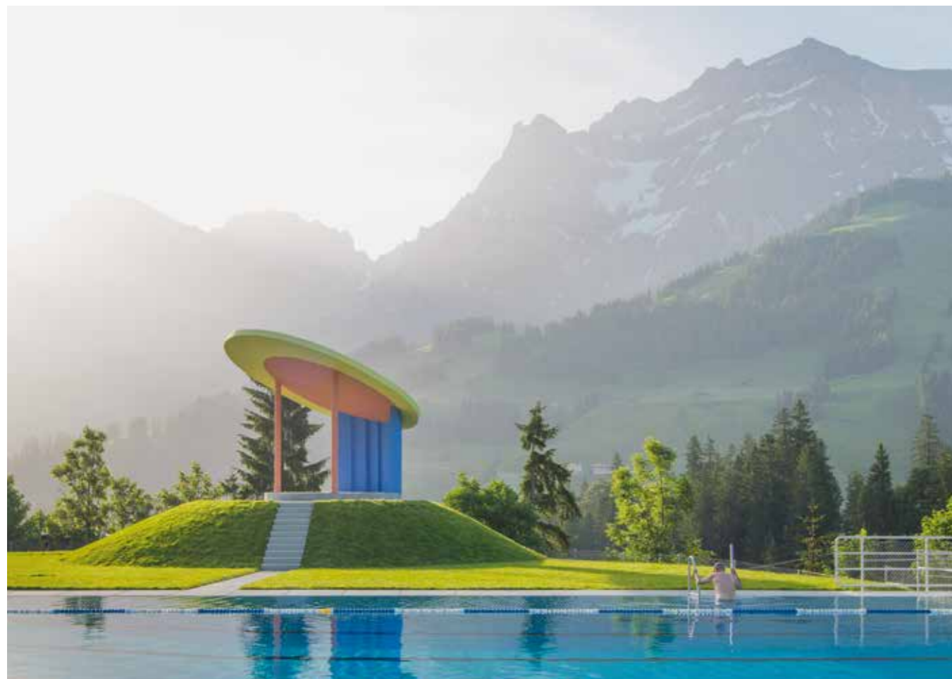
Bauherrschaft Gemeinde Adelboden; Architektur/Baumanagement Akkurat Bauatelier GmbH, Thun; Landschaftsarchitektur Duo Landschaftsarchitekten Särl, Lausanne; Bauingenieurwesen Emch + Berger AG, Spiez; Elektroplanung Elektroplan Buchs & Grossen AG, Frutigen; Haustechnik Beck Schwimmbadbau AG, Winterthur; Kultur/Kunst am Bau Roger Tinguely, Steffisburg/Maja Fluri, Bellach; Fertigstellung 2019; Adresse Risetensträssli 22, 3715 Adelboden; Fotografie Rolf Mühlethaler, Bern
